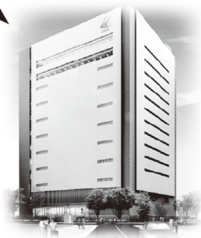
EneWings広島データセンター
